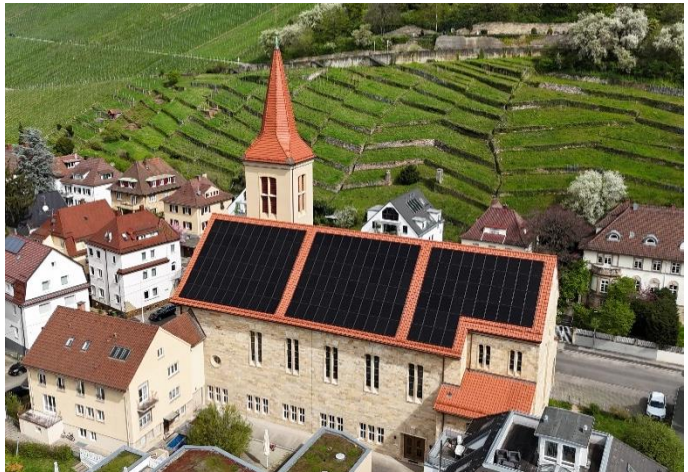
St. Franziskus/S.-Obertürkheim: PV-Anlage der BürgerEnergie Stuttgart; Foto: Dr. Boris Misis
